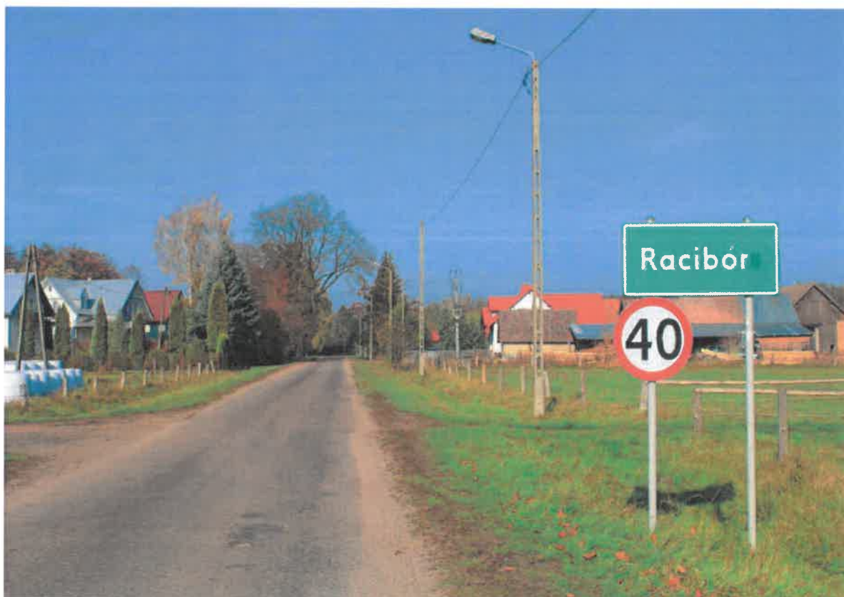
Odcinek drogi powiatowej 1681N (Racibór)
