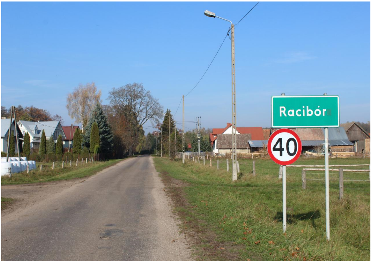
Odcinek drogi powiatowej 1681N (Racibór)
