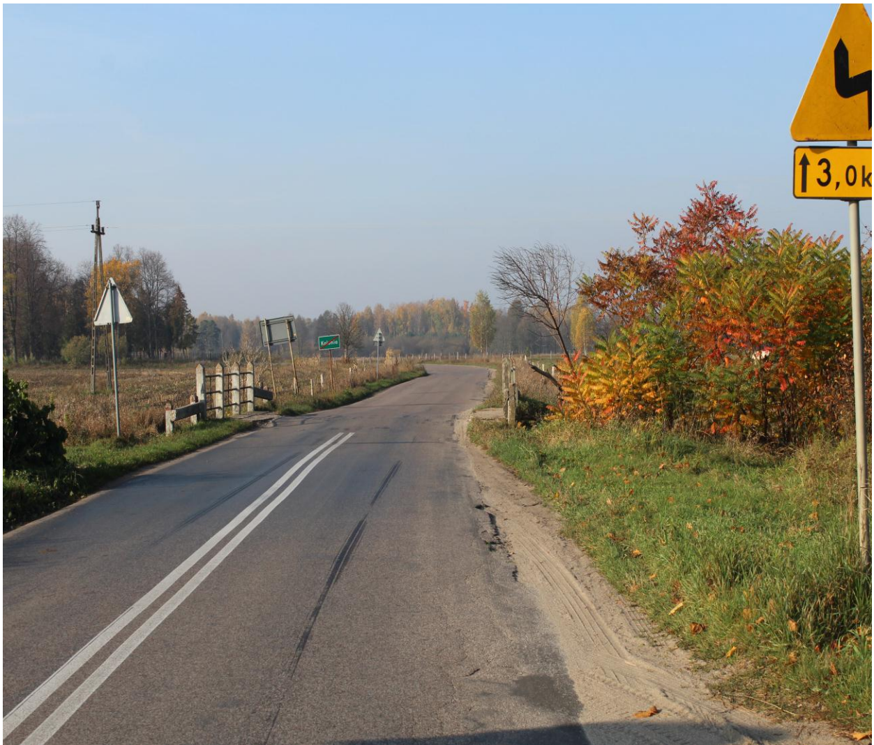
Fragment przewidzianej do modernizacji w 2020 r. drogi powiatowej nr 1504N
