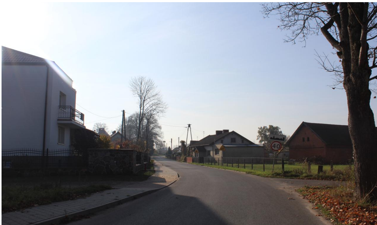
Droga powiatowa nr 1681N po modernizacji w 2013 roku
